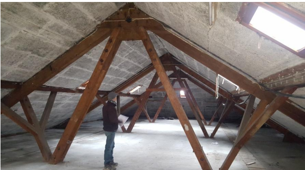
Abb. 25: Dachstuhl im Westflügel mit geringem Quartierpotenzial für Fledermäuse
