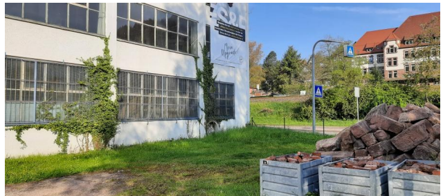
Abb. 10: Ansicht der östlichen Seite des Ostflügels mit vorgelagerter Ruderalfläche
