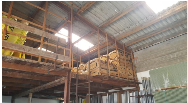
Abb. 37: Hochlager im Lagerschuppen Karlstraße Nr. 9. Unterhalb des Wellblechdachs befinden sich Hochlager.
