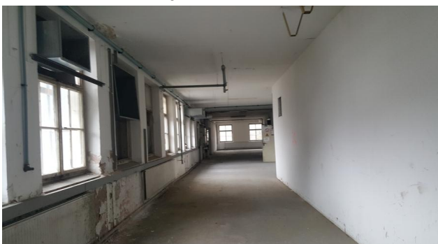
Abb. 23: Gang zwischen zwei ehemaligen Fabrikhallen
