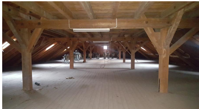
Abb. 26: Dachstuhl im Westflügel mit mittlerem Quartierpotenzial für Fledermäuse
