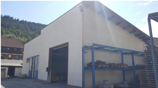
Abb. 36: Außenansicht von Gebäude Karlstraße Nr. 9, welches als Lagerschuppen für Baumaterialien verwendet wird.
