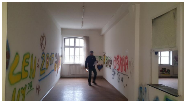
Abb. 24: Gang im ersten Stock des Gebäudes
