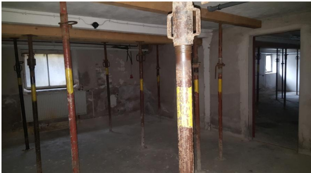
Abb. 15: Ansicht der Kellerräume unterhalb des Westflügels
